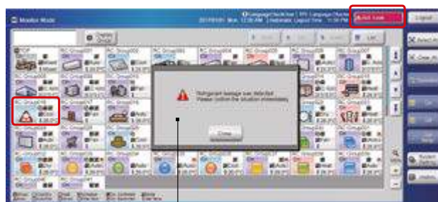
Wyskakujące okienko z informacją o wycieku
